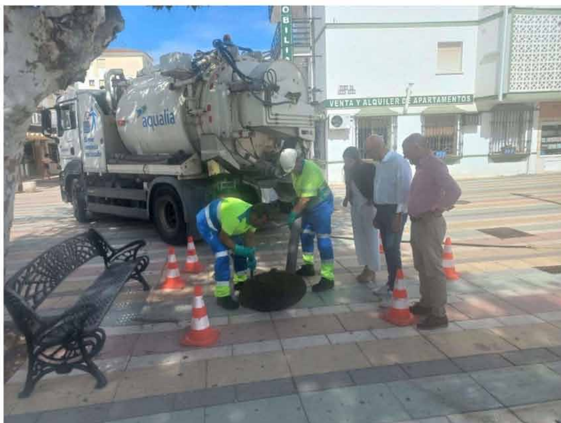
Supervisión trabajos limpieza alcantarillado Aqualia Lepe
