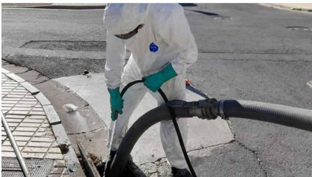
Se han limpiado ya 79 km de tuberías de saneamiento, 1.009 rejillas de alcantarillado y 2.200 pozos de saneamiento
