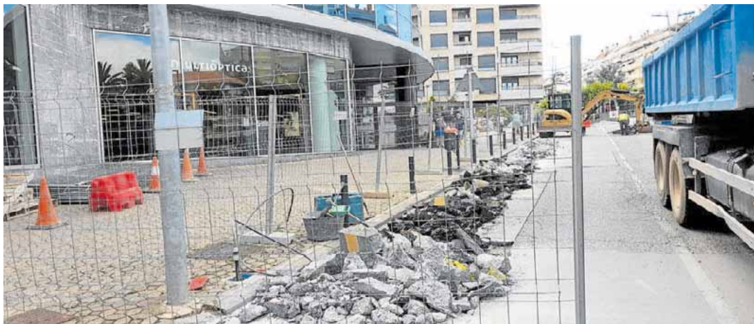
Inicio de las obras frente al centro comercial Arcca de Calahorra esta semana. SANDA
